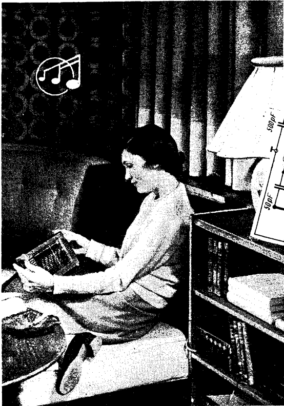
Bild 1 (links). Der Bedienungsteil, nicht wesentlich größer als eine Abstimmkala, enthält den vollständigen Hf- und Zf-Teil einschließlich Demodulator und Abstimmanzeiger. Er läßt sich überall in der Wohnung bequem aufstellen, z. B. auf dem Schreibtisch, auf dem Büchergestell oder auf dem Teewagen
