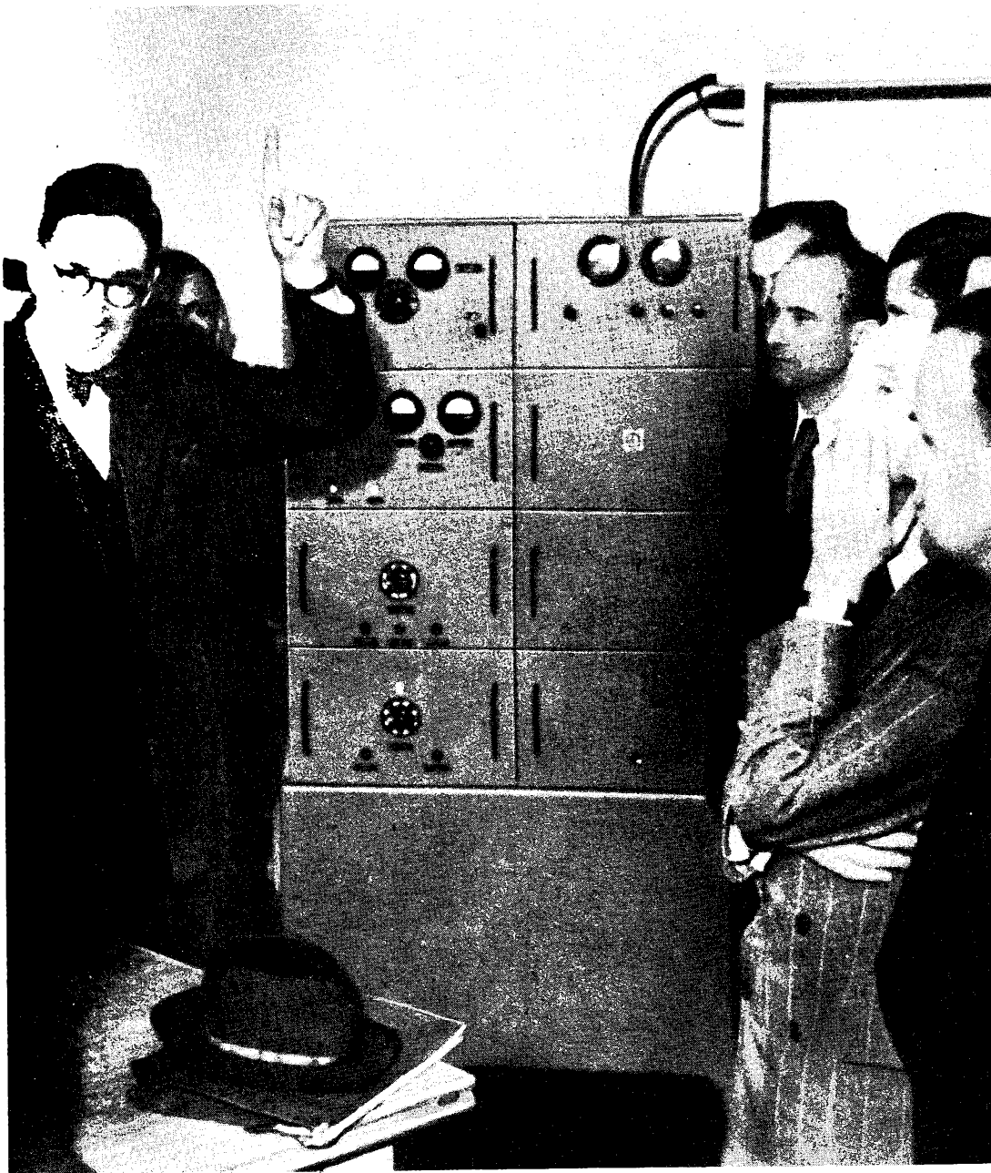
Bei einer Pressebesichtigung des von Telefunken errichteten UKW-Senders Hannover gab der Technische Direktor des NWDR., Herr Dr. Nestel, Erläuterungen über Ausbreitung der Ultrakurzwellen und den Aufbau des Ultrakurzwellenrundfunks. Der in Hannover verwendete UKW-Sendertyp soll auch in anderen deutschen Städten aufgestellt werden. Durch die Errichtung zahlreicher UKW-Versuchssender wird der deutschen Industrie die Möglichkeit zur Erprobung entwickelter UKW-FM-Empfänger gegeben. (Aufnahme: Telefunken)
