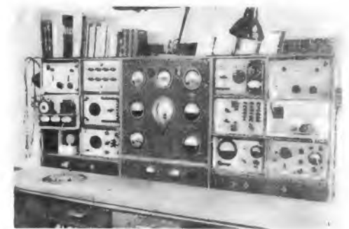
Bild 1. Ansicht des Reparaturplatzes
