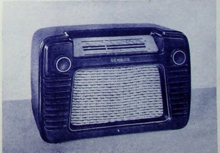
Bild 3. Ein gutes Beispiel für elegante Preßstoff-Gehäuseformen bietet der 4-Kreis-SuperSchaub „Junior 50“, der in Aufmachung und Ausstattung hohe deutsche Wertarbeit verkörpert und einen vielseitigverwendbaren Gebrauchssuper mit neuzeitlicher Schaltung darstellt
