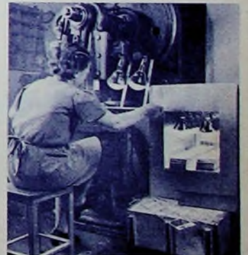
Bild 1. Hartpapier-Streifen werden vor dem Stanzen mit Philips-Infrarot-Strahlern vorgewärmt
