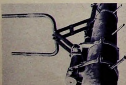
Bild 2. Einzelnes Strahlerelement der Spezial-UKW-FM-Antenne, das sich durch Warmluft heizen läßt
