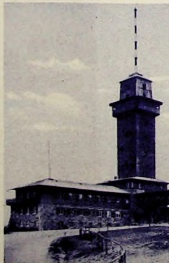
Bild 1. Der UKW-FM-Sender Feldberg arbeitet mit einer Pylon-Rundstrahl-Antenne
