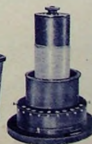
Bild 3. Eine Detektorempfängerspule aus dem Jahre 1900 mit den damals üblichen riesengroßen Abmessungen
