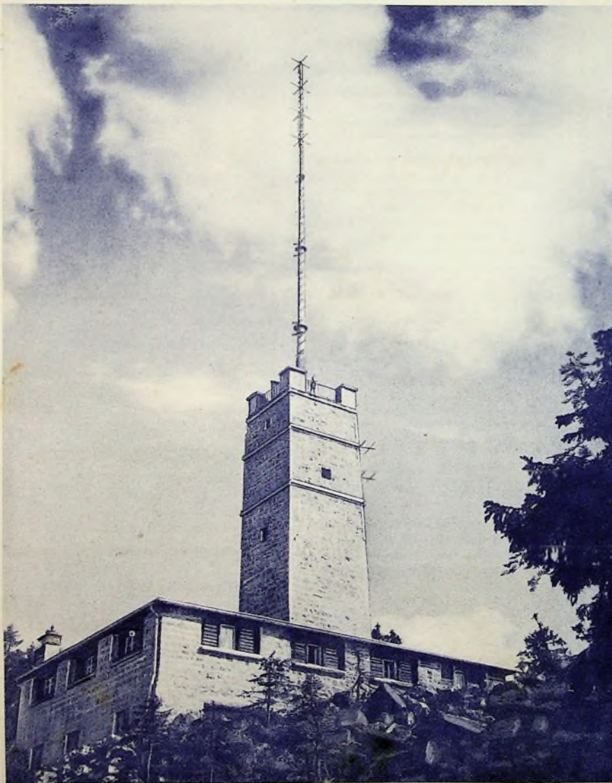
Seit Mitte Oktober hat der neue 10-kW-UKW-FM-Rundfunksender des Bayerischen Rundfunks auf dem Ochsenkopf (Fichtelgebirge) in 1025 m Höhe den Versuchsbetrieb (Frequenz 88,5 MHz) aufgenommen. Die Sendeanlage gehört zu den modernsten Anlagen und verwendet eine 4-fach-Quirlantenne mit Horizontalcharakteristik. Der Antennenschiff, der die eigenliche Sendeantenne trägt, besitzt einen Durchmesser von 42 cm. (Archivfoto: Technische-Direktion, Bayerischer Rundfunk)
