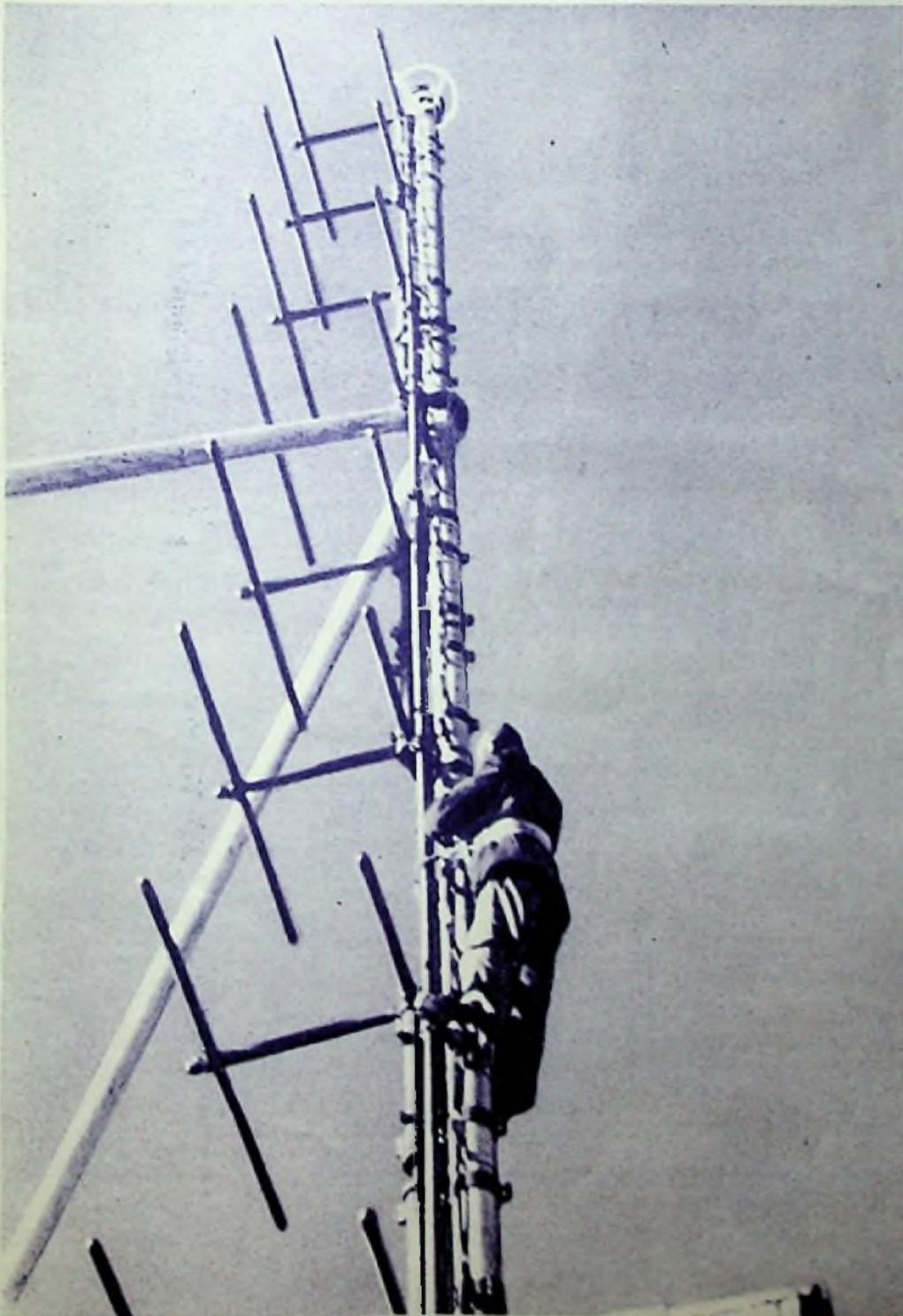
Auf dem Wendelstein wurde zur Erhöhung der vertikalen Bündelung und der Empfangsfeldstärke eine neue, von der Firma Rohde & Schwarz gebaute 8fach-UKW-Dipol-Reflektor-Antenne aufgestellt. Der Wendelstein-Sender überträgt das Programm des Bayerischen Rundfunks auf 89,3 MHz. (Foto: Kreis).
