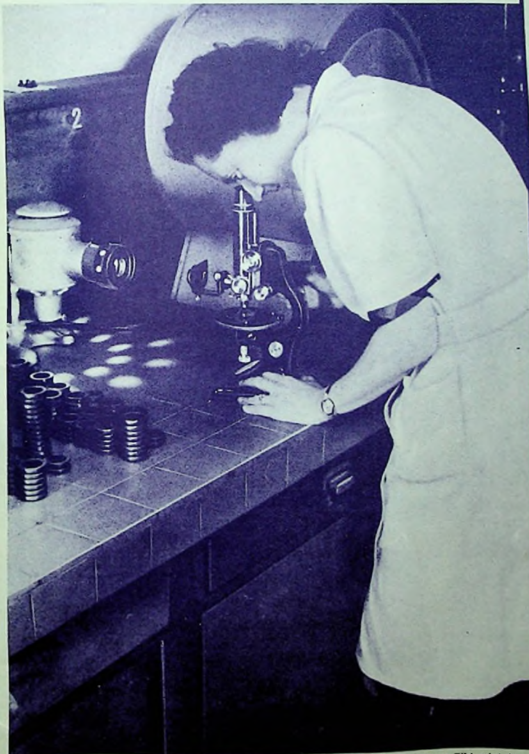
Die Herstellung von Ferrocarr-Bauteilen verlangt sorgfältige Materialprüfungen. Dieses Bild zeigt die optische Untersuchung von Hf-Eisenkernen, wie sie von der Firma Vogt & Co. vorgenommen wird. (Werkbild)
