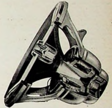
Der „feinste“ Lautsprecher der Welt enthält drei vollständige Lautsprechersysteme mit getrennten Magneten und Schwingspulen
