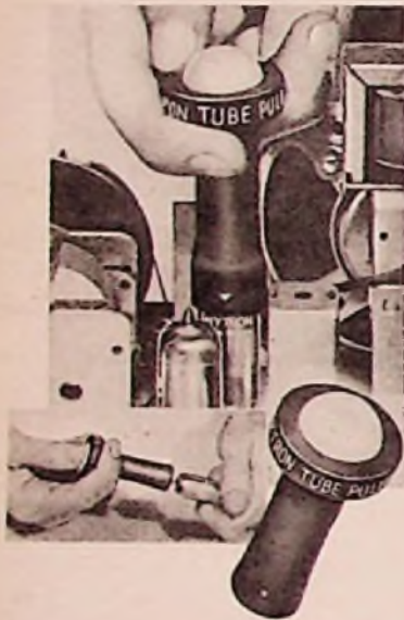
Der neue Hytron-Röhrenzieher für Miniaturröhren
