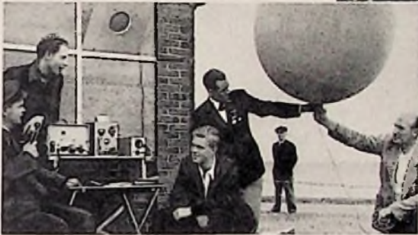
Die 20-Watt-Amateurstation der Firma See-Funk-Nord. Oben befindet sich der Sender. Darunter sieht man den 5-Röhren-7-Kreis-Super für alle Amateurbänder. Links: Die 80-m-Kleinstation am Strand v. Cuxhaven. Links sieht man das Stromversorgungsgeräat, daneben befinden sich Sender u. Empfänger. Die Vertikalantenne wird durch einen Ballon (im Bild vor dem Start) hochgehalten. (Aufn. Albert Inderhees)
