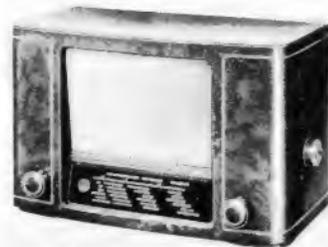
sprecher (205 mm) und in größerem Edelholzgehäuse (58x38x25 cm), Preis 339 DM. Außerdem wird seit einiger Zeit der Typ 401 geliefert, bei dem auf Klang und UKW-Empfindlichkeit besonders großer Wert gelegt wurde. 8 Röhren + Selen, 8 AM- und 9 FM-Kreise, Radiodetektor höchster Empfindlichkeit, großer 6-W-Lautsprecher und großes Edelholzgehäuse kennzeichnen diesen Empfänger; Preis 395 DM. So bietet Metz praktisch ein vollständig neues Programm, das in preislicher Hinsicht sehr bemerkenswert ist.
