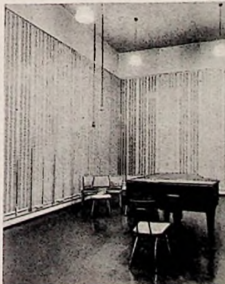
Studio mit wandelbarer Akustik im Funkhaus Köln. Durch Verstellen der Schlitzbretten in den Wänden kann der Schall mehr oder weniger reflektiert oder verschluckt werden. (Aufnahme: Walter H. Schmitt).
