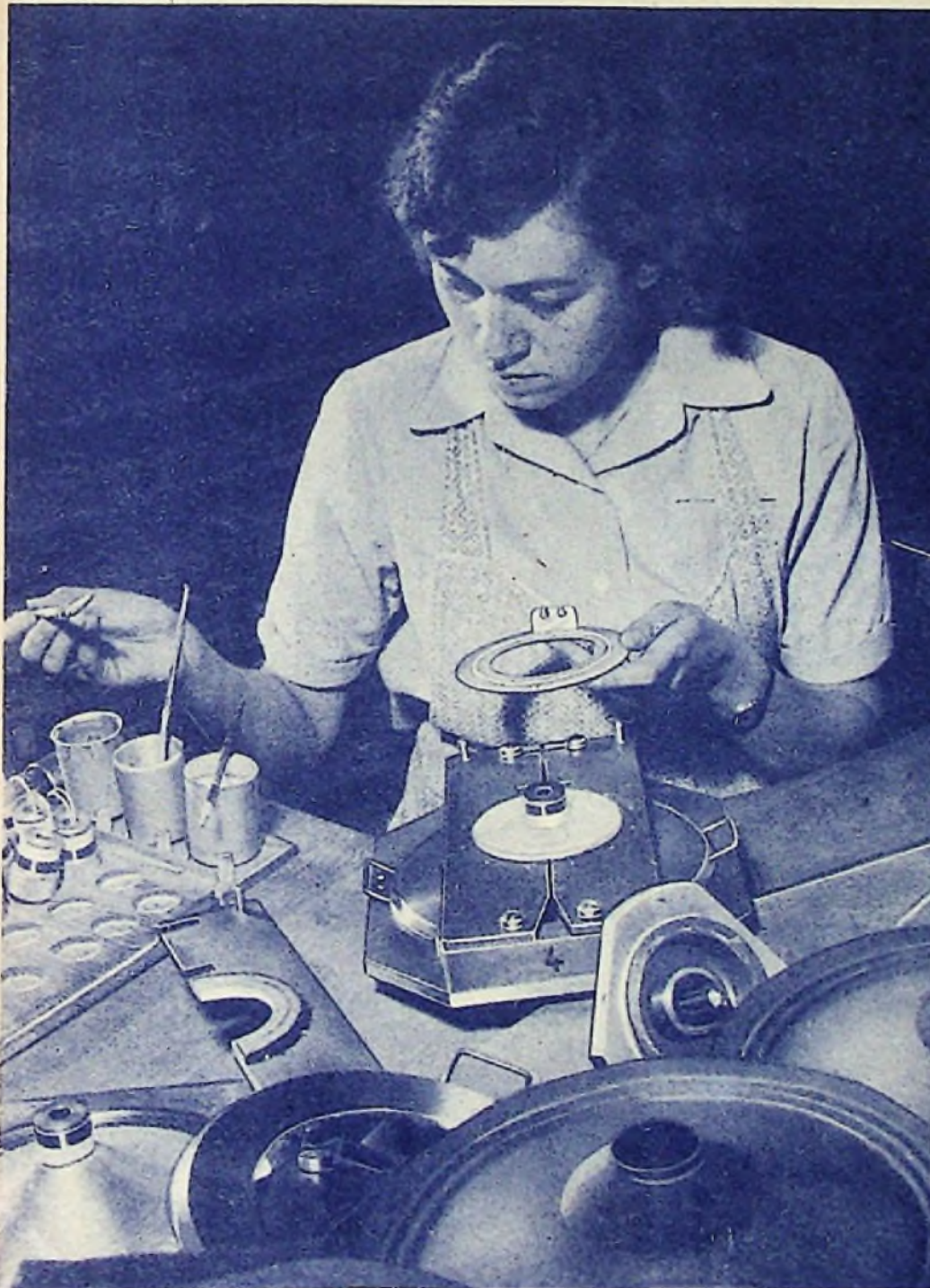
Bei den Geräten der neuen Saison wird der Klangqualität und damit den Lautsprechern ganz besondere Aufmerksamkeit gewidmet. Hier ein Bild aus der Fertigung der Lorenz-Celophon-Lautsprecher. Genau gearbeitete Spannvorrichtungen sorgen für einwandfreie Zentrierung sowohl beim Verkleben der leichten Schwingspule mit der elliptisch gekrümmten Membran als auch beim Aufsetzen der Gewebezentrier-membran und ihrer ringförmigen Halterung. (Aufnahme: C. Stumpf)
