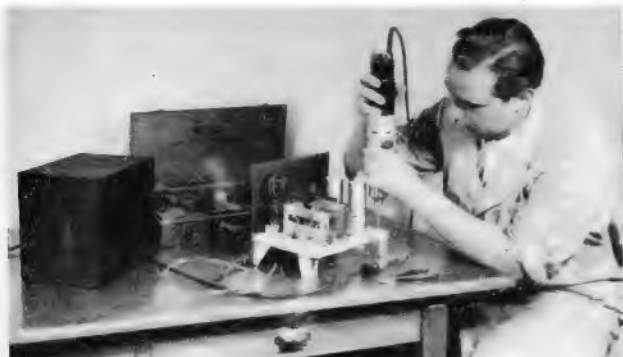
Bild 2. Verwendung des Bosch-Combi-Elektrowerkzeuges als Handbohrmaschine
