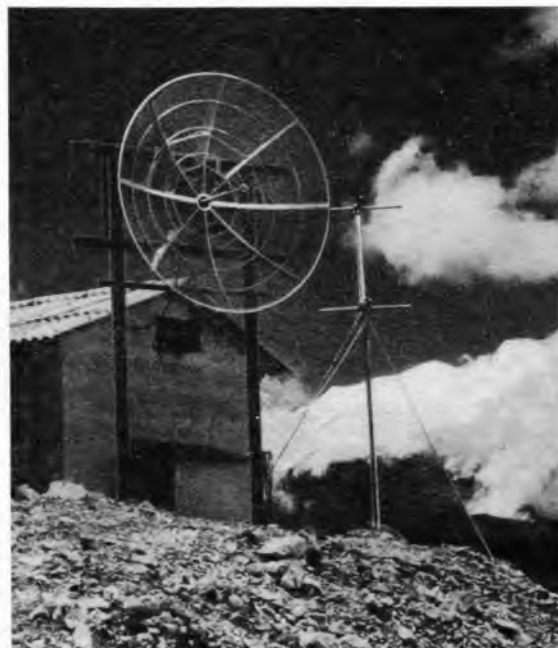
Neben dem Fernseh-Antennenturm der 15-cm-Parabolspiegel für Mehrfachtelefonie Mexiko-Hauptstadt - Puebla (bis zu 23 Gespräche) auf dem Altzomoni. Im Hintergrund der Popocatepetl mit 5450 m ü. M.
