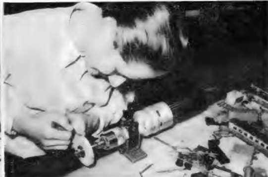
Bild 3. Nachschleifen von Werkzeugen
