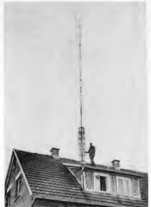
Antennenmast für eine drehbare Fernsehantenne
