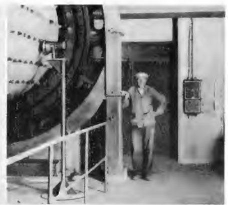
Bild 4. Die Regeleinrichtung im praktischen Betrieb einer Zementmühle
