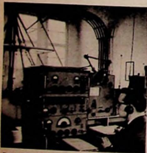
Frequenzmeßplatz in Norddeich-Radio. Hier wer-den täglich 70 Messungen elgoner und fremder Senderfrequenzen durchgeführt
