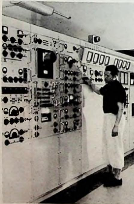
Bild 1. Abstimmfeld eines der 20-kW-Kurzwellensender (Telefunken) in der Überseefunkstelle Usingen. Der Frequenzwechsel geschieht sehr rasch; es kann auf jede beliebige Frequenz mit Quarzkonstanz kontinuierlich durchgestimmt werden
