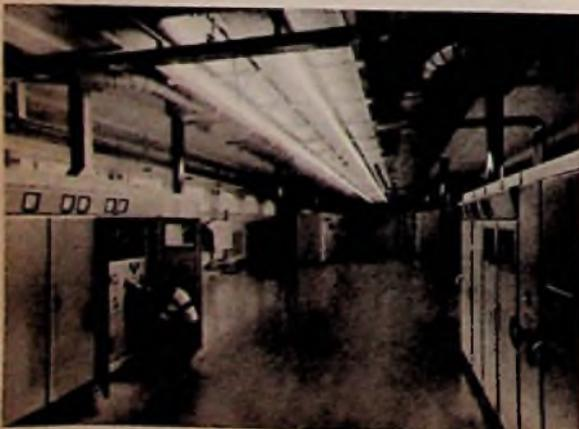
Links: Bild 2. Unter dem Sendersaal befindet sich dieser Raum für die Stromversorgungs- und Gleichrichteranlagen; die entsprechenden Aggregate sind jeweils direkt unter den darüber stehenden Sendern angeordnet
