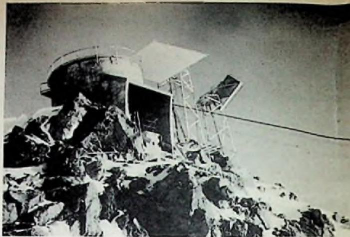
Bild 6. Die beiden rhombischen Umlenkspiegel auf der Valluga (2811 m)
