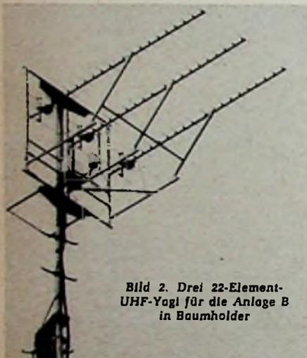
Bild 2. Drei 22-Element-UHF-Yagi für die Anlage B in Baumholder
