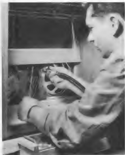
Bild 1. Ein Druckluftschauber bei der Lautsprechermontage
