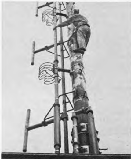
Die UKW-Sendeantenne für WEFM, Chicago, auf dem Field Building ist in zwei Ebenen polarisiert
