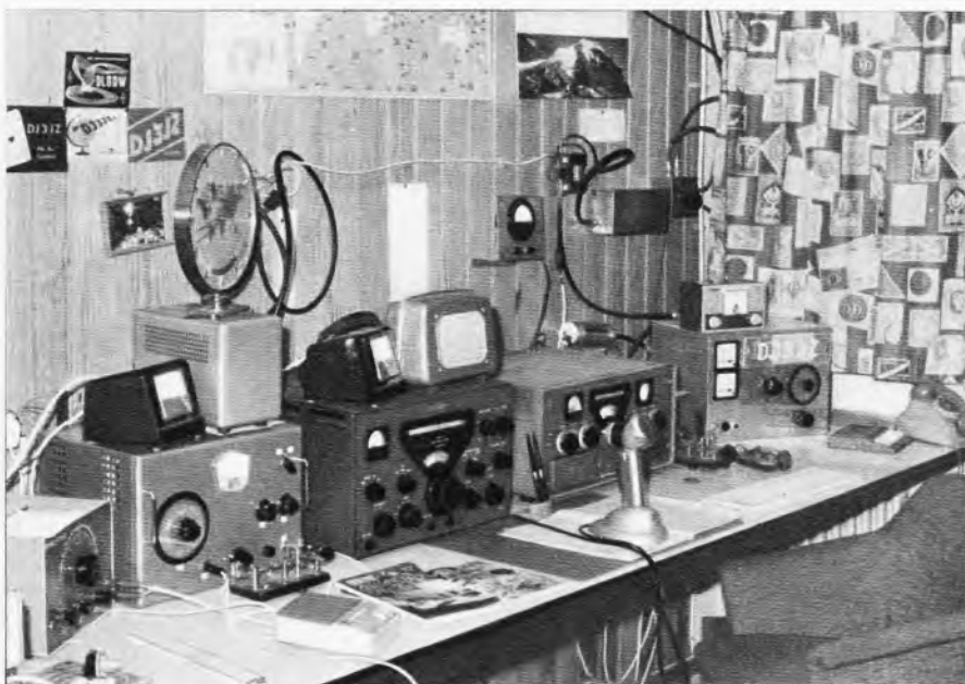
Moderne Amateurfunkstelle für Kurz- und Ultrakurzwellen. Eine Weltzeit-Uhr und die Fernbedienung für die drehbare Richtantenne deuten darauf hin, daß sich der Besitzer auf DX-Verkehr spezialisiert hat
