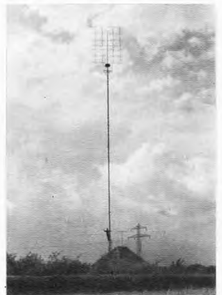
Bild 3. Einer der imponierendsten, selbstgebaute Amateur-UKW-Drehrichtstrahler. In über 30 m Höhe ist eine 48-Element-Dipolzeile für das 2-m-Band montiert. Der Eigentümer, OM Herbst, DL 3 YB, betreibt bei ARTOB-Experimenten seine Station als Leitstelle
