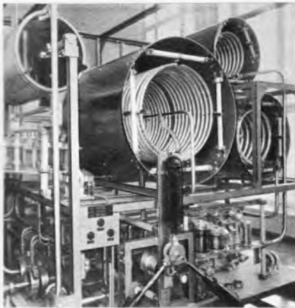
Bild 2. Posthumus-Brücke in offener Bauweise zur Parallelschaltung von zwei Telefunken-Mittelwellen-Großsendern
