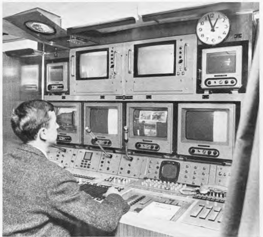
Bild 1. Bildregie mit Farb- und Schwarzweiß-Monitoren im neuen, 11,5 m langen und 20 t schweren Farbfernseh-Übertragungswagen des Norddeutschen Rundfunks. Er hat drei getrennte Räume für Bildregie, Bildtechnik und Tonregie/Tontechnik. Die vier mitgeführten Plumbikon-Farbfernsehkameras können bis zu 600 m entfernt vom Wagen arbeiten und brauchen nur etwa 60% mehr Licht als Schwarzweißkameras, d. h. 1500 Lux. Über den Übertragungswagen und weitere Einzelheiten der Farbfernseh-Vorbereitungen des NDR wird ein Beitrag in Heft 11 berichtet
