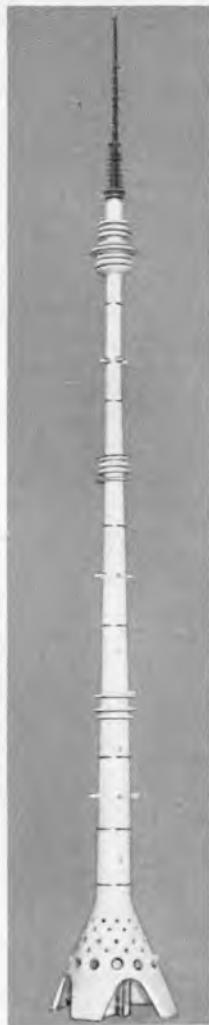
Bild 3. Modell des 525 m hohen Moskauer Fernmeldeturms mit Aussichtsplattformen und dreistöckigem Restaurant für insgesamt 800 Besucher. Der Rohbau hat bereits 385 m überschritten
