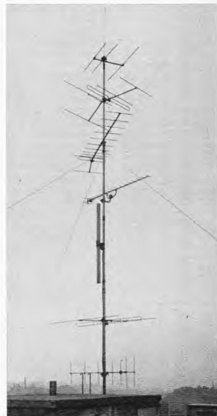
Eine hochgestockte Mehrzweck-Antenne in Zürich für drei Fernsehprogramme, UKW-Rundfunk aus zwei Richtungen und zwei kommerziellen Funk- bzw. Fernseh-Verbindungen
