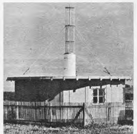
Bild 5. VOR-Station Spielberg/Schwarzwald, ein mittelwelliges Drehfunkfeuer im Bereich um 115 MHz Foto: SEL
