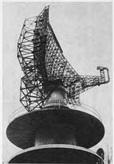
Bild 10. Antenne des Mittelbereichs-Radargerätes auf der Deisterhöhe bei Hannover (siehe Bild 9) Foto: Telefunken
