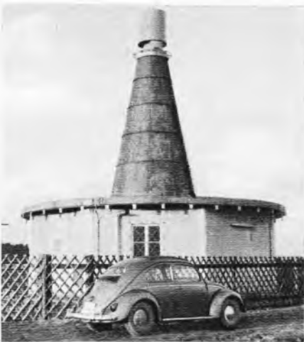
Bild 7. VORTAC-Station Fulda auf 112,9 MHz. Entsprechend ausgestattete Flugzeuge können ihre Richtung zu und die Entfernung von dieser Station automatisch ermitteln. Foto: SEL
