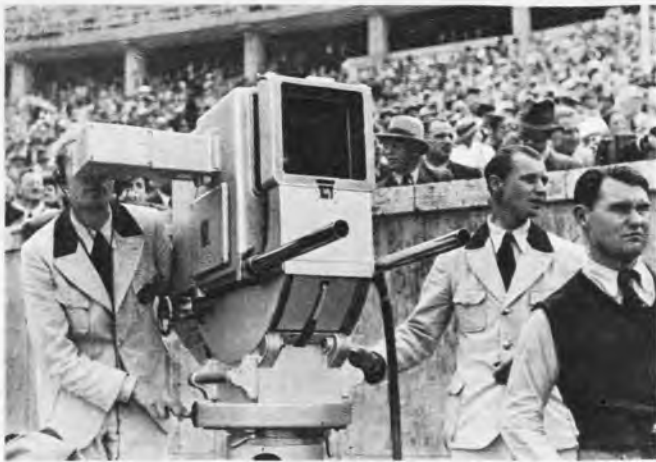
Die große Olympia-Kamera mit Ikonoskop auf dem Reichssportfeld, Berlin, im Jahre 1936, hier ohne das schwere Teleobjektiv mit langer Brennweite. Die ungefähre Einrichtung wurde damals „Bildfänger“ genannt. Links am Sucher: Walter Bruch, 28
