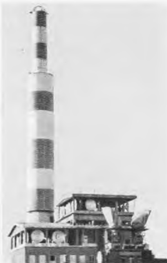
UKW- und Fernseh-Antennenanlage auf dem 2300 m hohen Botev Vrch in Bulgarien. Ein überwiegend aus Kunststoff bestehender Eisschutzzyylinder schützt die Antennenelemente vor extremen Witterungseinflüssen (Werkaufnahme: Rohde & Schwarz)
