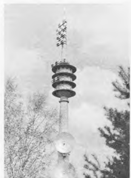
Bild 3. Der Fernmeldeturm auf dem Schäferberg in West-Berlin im heutigen Ausbaustand. Er wurde bereits am 17. Juli 1964 seiner Bestimmung übergeben (Aufnahmen: Dennewitz)
