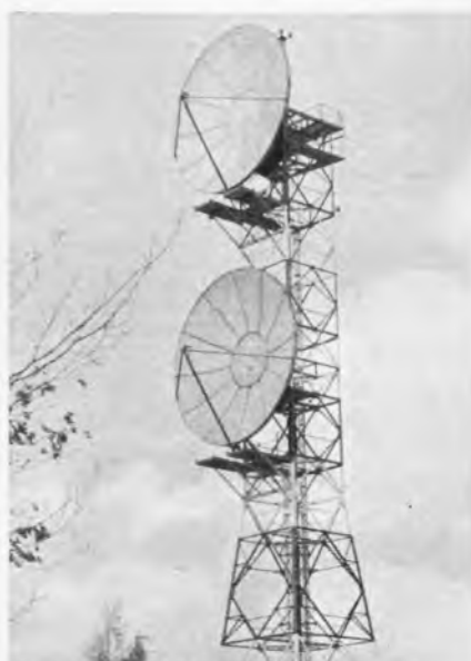
Bild 2. Der erste Gittermast auf dem Schäferberg mit zwei 10-m-Parabolspiegel für eine Überreichweitensystem im 2-GHz-Bereich (Baujahr 1959)
