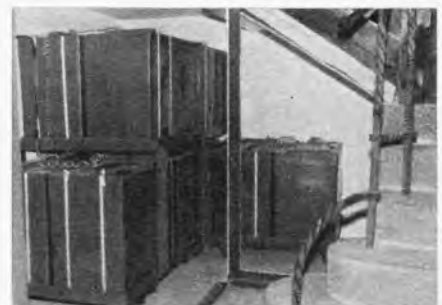
Bild 2. Aus dieser Batterie galvanischer Primärelemente wird der Umsetzer gemäß Bild 1 gespeist. Die Kapazität ist 10 000 Ah, die Lebensdauer etwa 1\frac{1}{2} Jahre
