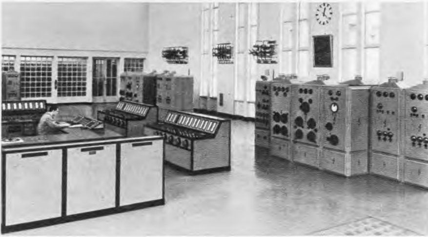
Bild 4. Senderhaus 4 in Zeesen mit vier 50-kW-„Olympia“-Sendern von Telefunken ab Juli 1936. Jeder Sender hatte sieben Stufen und war mit zwei je 25 kW leistenden Endstufen ausgestattet. Eine 25-kW-Endstufe enthielt 2 \times 2 RS 257 parallel und in Gegentakt; beide Endstufen wurden von der gemeinsamen fünften Stufe ( 2 \times RS 207) angesteuert
