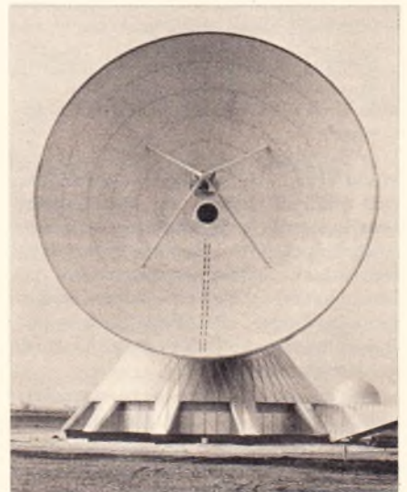
28,5 m beträgt der Durchmesser des neuen Antennenspiegels von Raisting II, der zur Zeit eingemessen wird
