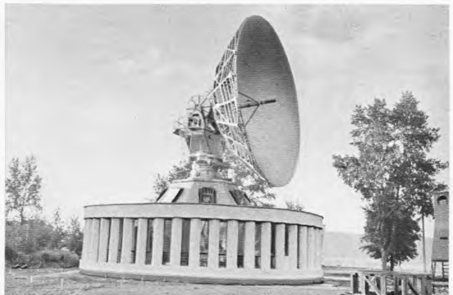
Bild 2. Eine der Standard-Bodenstationen für das russische System der Nachrichtensatelliten mit 12-m-Parabolspiegel. Diese Station steht im Gebiet Kemerowo zwischen Nowosibirsk und Krasnojarsk
