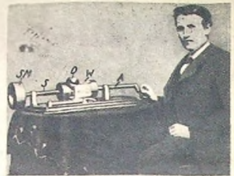
Abb. 2. Edison mit seiner Phonographenmaschine, die als Anzeigekolben, die Wachsvalze, die Sprechmuschel, die Spindel, mit Schwingungsmasse
