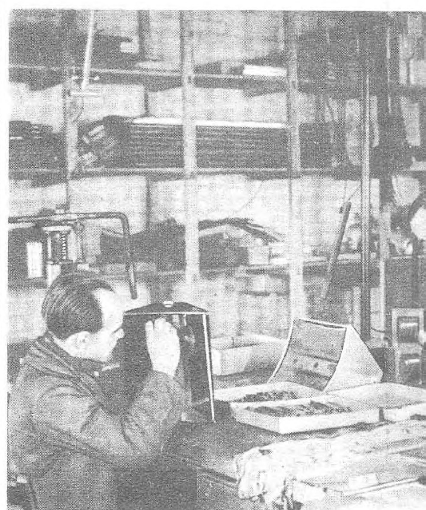
Links: Montage der Drossel auf den Stativfuß
