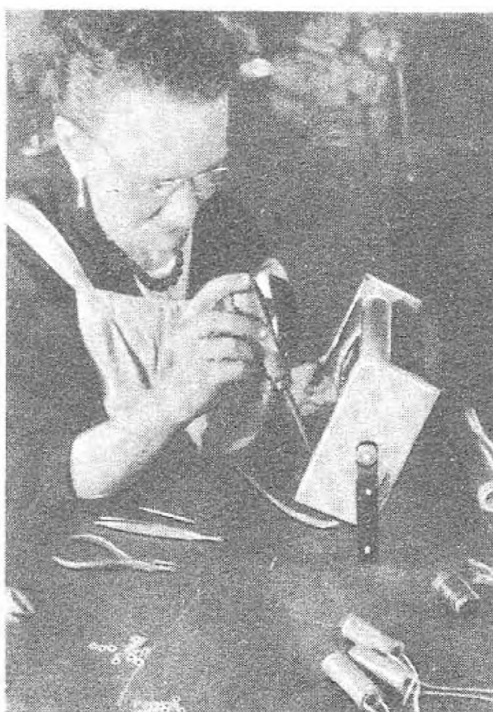
Einbau der Einzelteile in das Reflektorgehäuse
