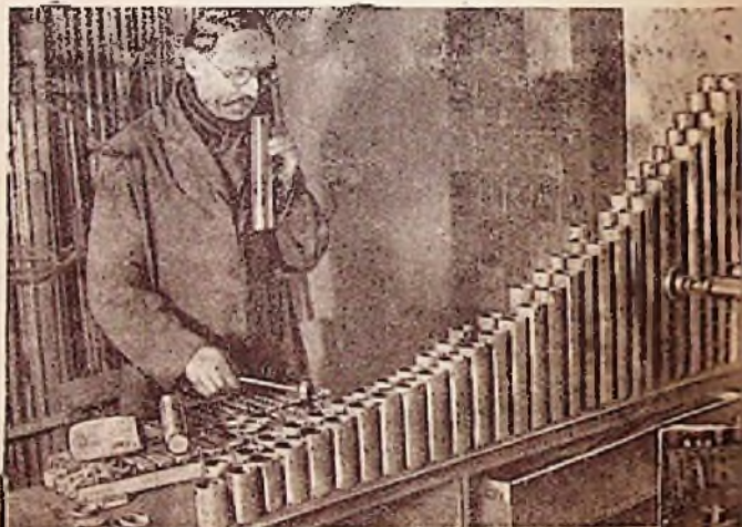
Die Resonanzröhren eines Pflaphons werden mit Hilfe eines Glockenspiels auf Tonhöhe abgestimmt
