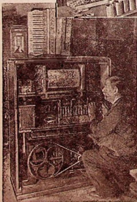
Die letzten Handgriffe an einem selbstspielenden elektrisch-pneumatischen Akkordeon, der besonderen Spezialität der Fa. F. Edel, der ältesten Berliner Harmonikfabrik
