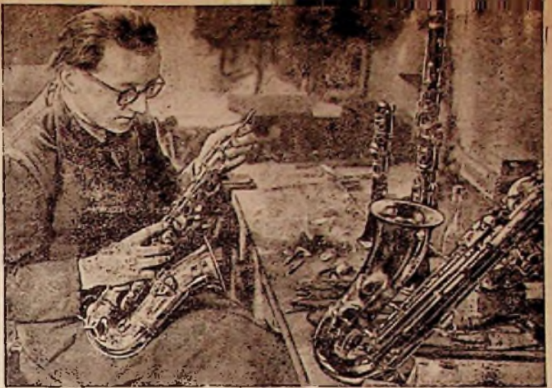
Instrumentenmacher beim Einpassen der Klappen eines Saxophons
