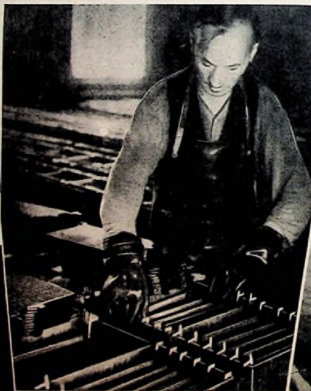
Abb. 8. Einhängen der Platten in die Säurebottiche zwecks Formieren
