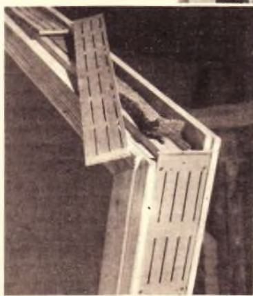
Der Falz der schweren Doppelflügeltüren wird mit Fitz und perforierten Sperrholzstreifen abgedichtet
