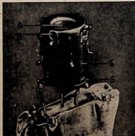
Abb. 5: Aufnahme des Wehneltzylinders der Elektronenstrahlröhre DG 9-3, G Wehneltzylinder, A Austrittsöffnung für die Elektronen, B Beobachtungsöffnung zur Montage des Systems, S Abschirmung gegen Streu-Elektronen
