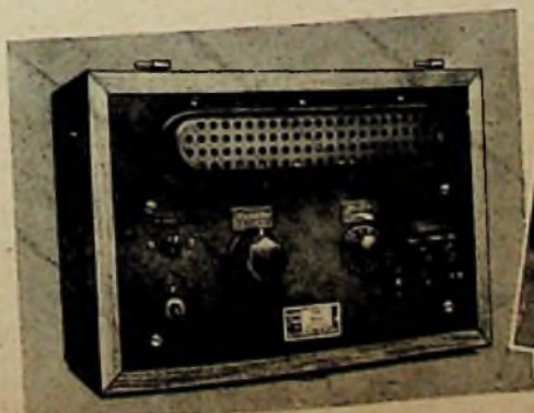
Rechts: ein Beispiel aus der Mende-Meßgerätereihe: Quarzgenerator TG 6 Frequenz 1 kHz ... 100 kHz
