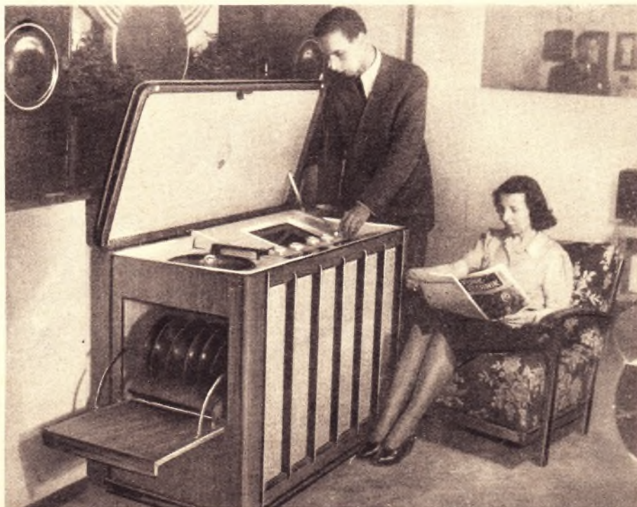
Blaupunkt-Musik-Truhe „8 W 749 T“ mit einem Siebenkreis-Achtröhren-Super für Wechselstrom sowie Plattenspieler und Plattenfach. Der Empfänger arbeitet auf Lang-, Mittel- und drei gespreizten KW-Bereichen. Zur Abstrahlung der 8 W Endleistung sind 2 Lautsprecher mit Tonführung eingebaut
