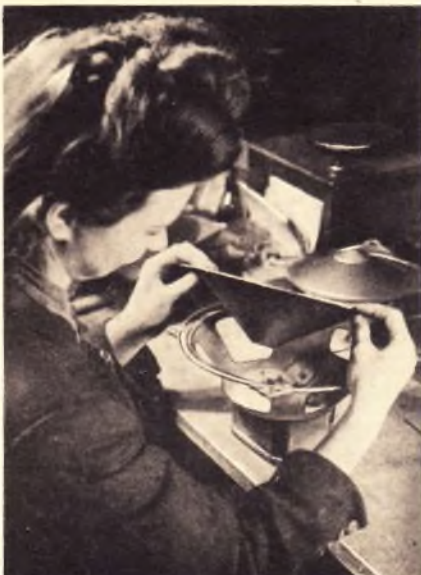
Kontrolle des Schlagens des Membranrandes mit Hilfe eines Plattenspieler
