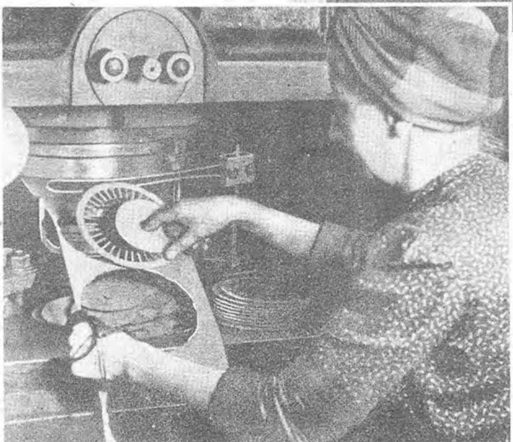
Ausstanzen der Bleche, aus denen das Blechpaket für die Aufnahme der Ständerwicklung hergestellt wird. Links: Durchbohren des Gehäuses für die Herausführung der Wicklungsanschlüsse
