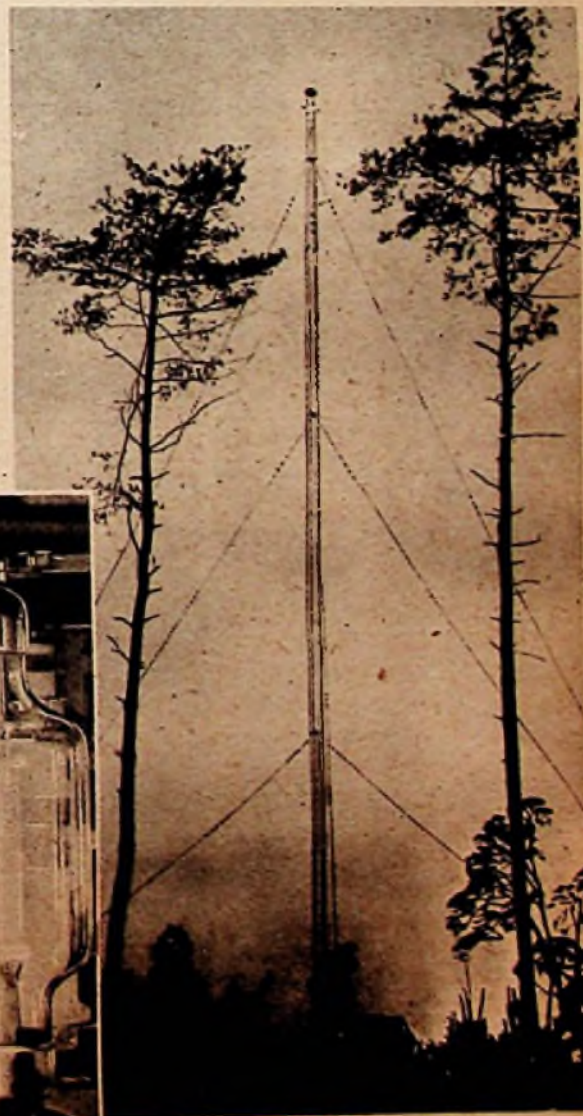
Rechts: Der etwa 50 m hohe Antennenmast des 5-kW-Senders in der Stallpöner Allee
