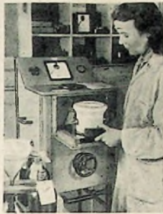
Untersuchung der Durchschlagsfestigkeit von Transformatorenöl. Den Studentinnen (links) werden die Kenntnisse in chemischen Vorgängen vermittelt, während ihre Kolleginnen (unten) in der Siemens-Werkschule Vergleichsmessungen von Gleichrichterröhren üben
