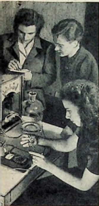
Untersuchung der Durchschlagsfestigkeit von Transformatorenöl. Den Studentinnen (links) werden die Kenntnisse in chemischen Vorgängen vermittelt, während ihre Kolleginnen (unten) in der Siemens-Werkschule Vergleichsmessungen von Gleichrichterröhren üben
