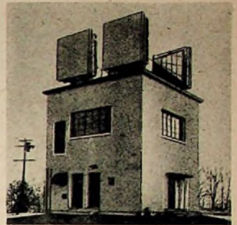
Abb. 8. Das Äußere einer Relaisstation. Die Vorderseite ist rechts, während die beiden Türen links zum Maschinen- und Heizungsraum führen
