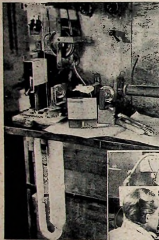
In der Kathodenherstellung wird die Elektronen emittierende Schicht auf den Heizfaden aufgebracht
