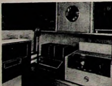
Die technische Einrichtung enthält u. a. eine komplette Verstärkerzentrale mit 60 W Ausgangsleistung
